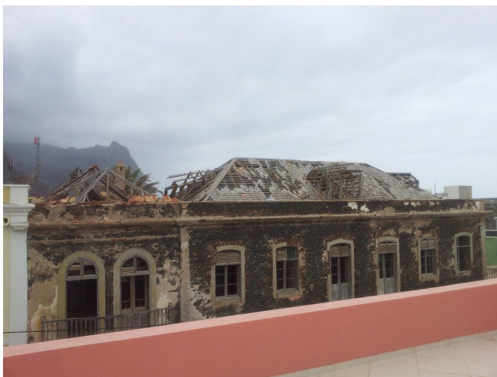
Sobrado Cohen (toiture / avant intervention de sécurisation / août 2016)
